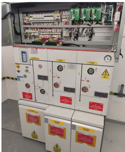
Rys. 2 Wnętrze stacji transformatorowej T-2846 przy WSM im. A. Mickiewicza w Sopocie po modernizacji wraz z tablicą informacyjną, transformatorem i rozdzielnicami SN/nn, (Energia-Operator SA, 2023).
